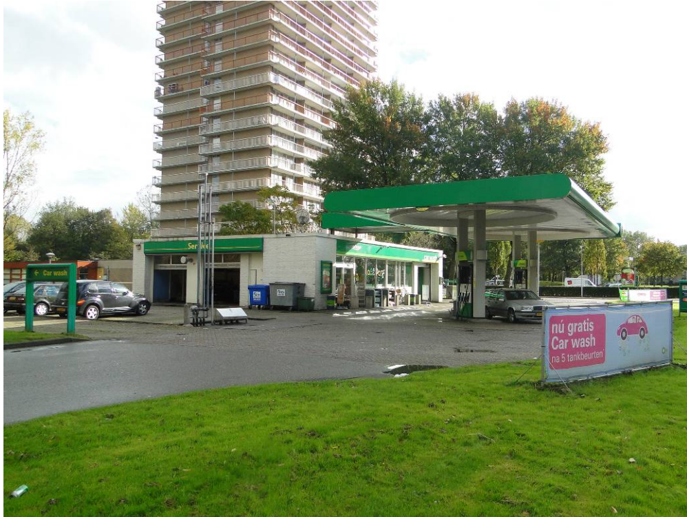
Foto 3. Benzineservicestation aan de van Aalstlaan 380
