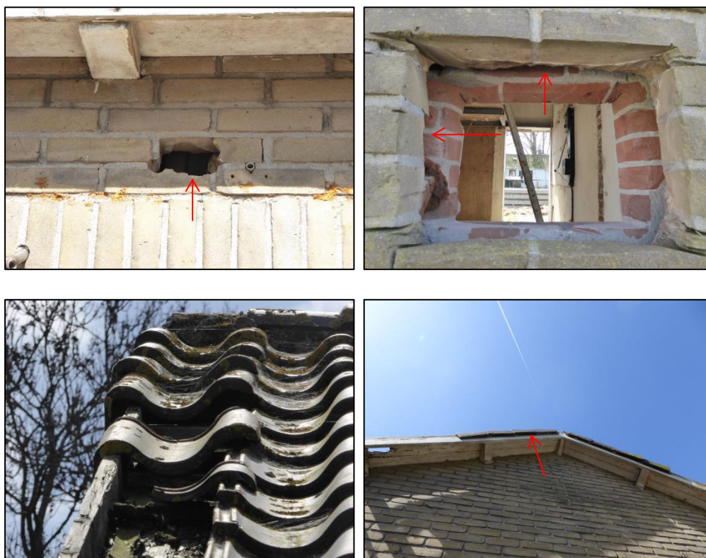
Toegang tot de spouw en ruimtes onder dakpannen.
