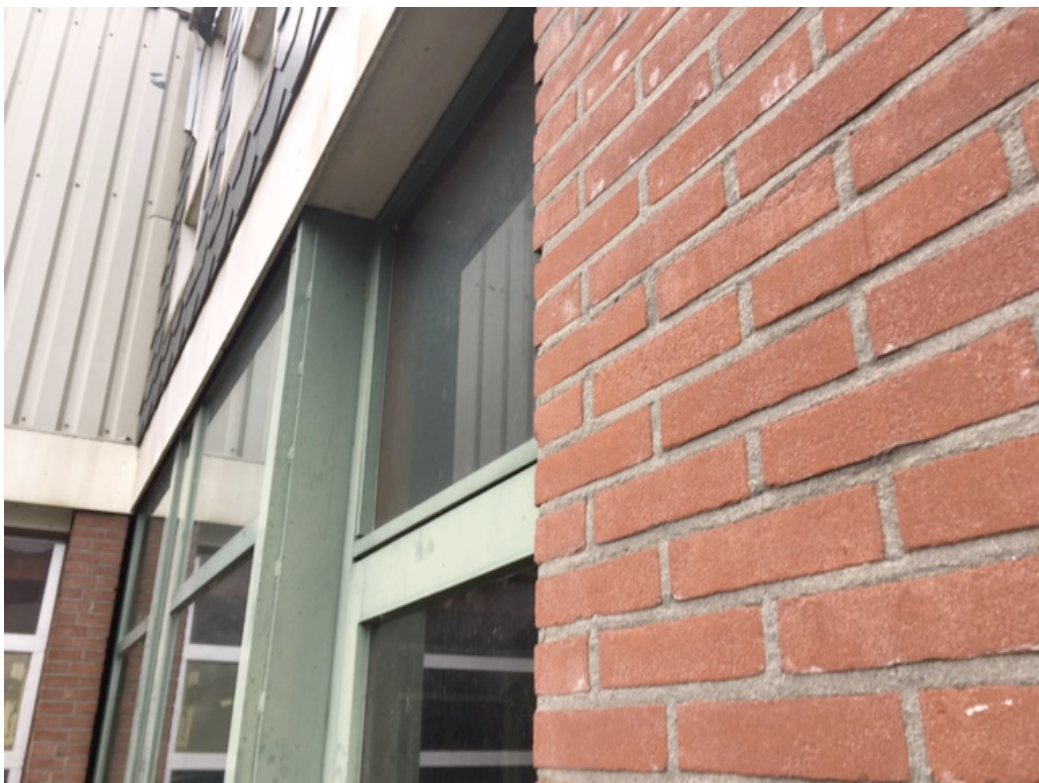
Foto 1. Zicht op een van de loodsen (gebouw met nummer 4). Te zien is dat er weinig tot geen wegkruipmogelijkheden (te ondiep, metalen beplating) zijn voor vleermuizen.
