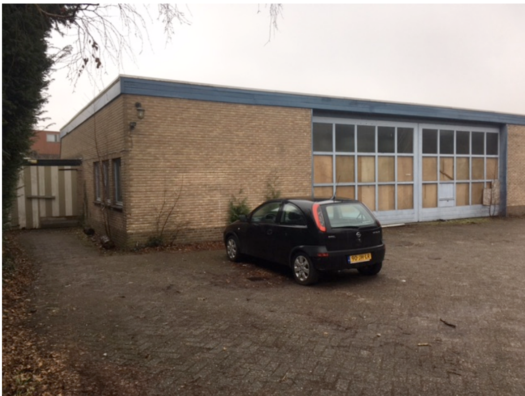
Foto 2. Zicht op de loods (gebouw met nummer 3) die enigszins geschikte verblijfplaatsen (paarverblijven) voor gewone dwergvleermuis en ruige dwergvleermuis kan bieden achter de dakrand.
