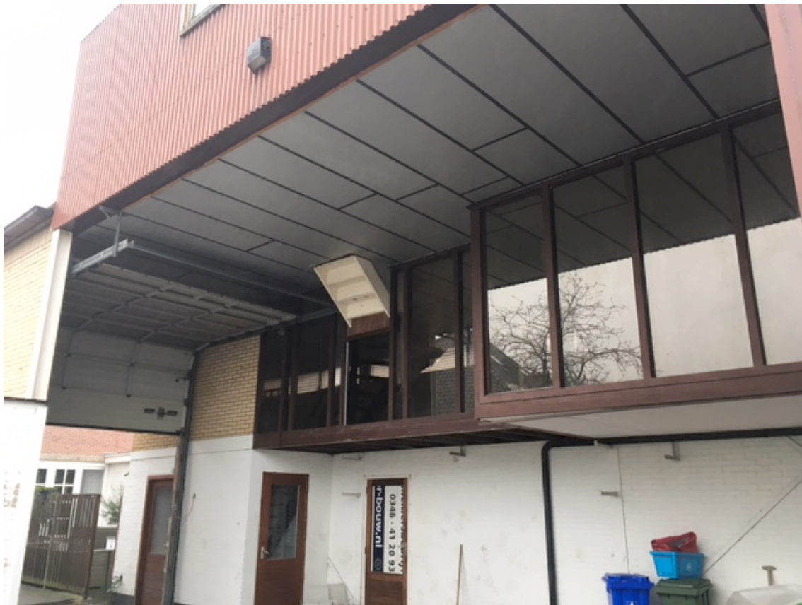
Foto 3. Zicht op te slopen bedrijfsruimte (gebouw 2). Ook hier ontbreken geschikte wegkruipmogelijkheden voor vleermuizen.
