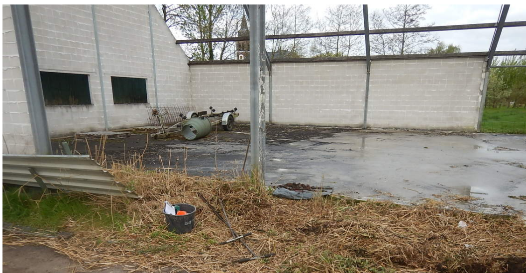
Figuur 7: Betonvloer bij niet afgebouwd pand.
