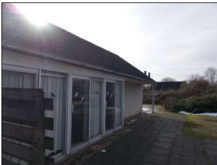
Figuur 7: Impressie gebouw 'E'.
