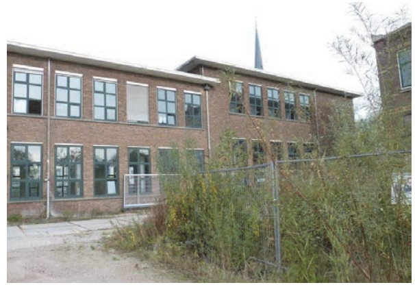
Figuur 6. Een te herstellen gebouw, met op de voorgrond de toegangsweg en achter het hek pioniersvegetatie.
