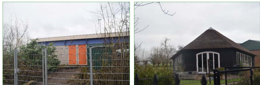
Op de foto links onder het clubgebouw op het tenniscomplex. De andere twee foto's laten de twee schuren op het erf van Hoofdweg 2 zien.
