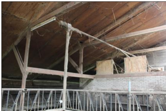
Foto 11 Binnenzijde dak stal D
