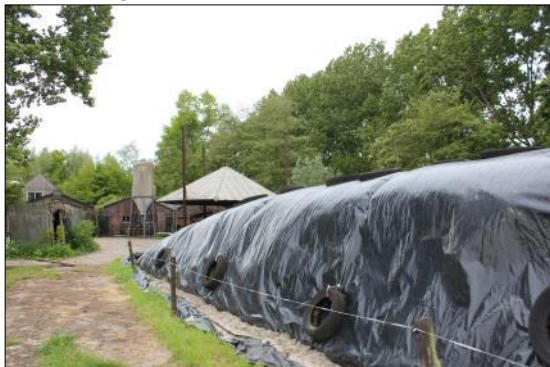
Foto 13 Afgedekt depot op betonplaat
