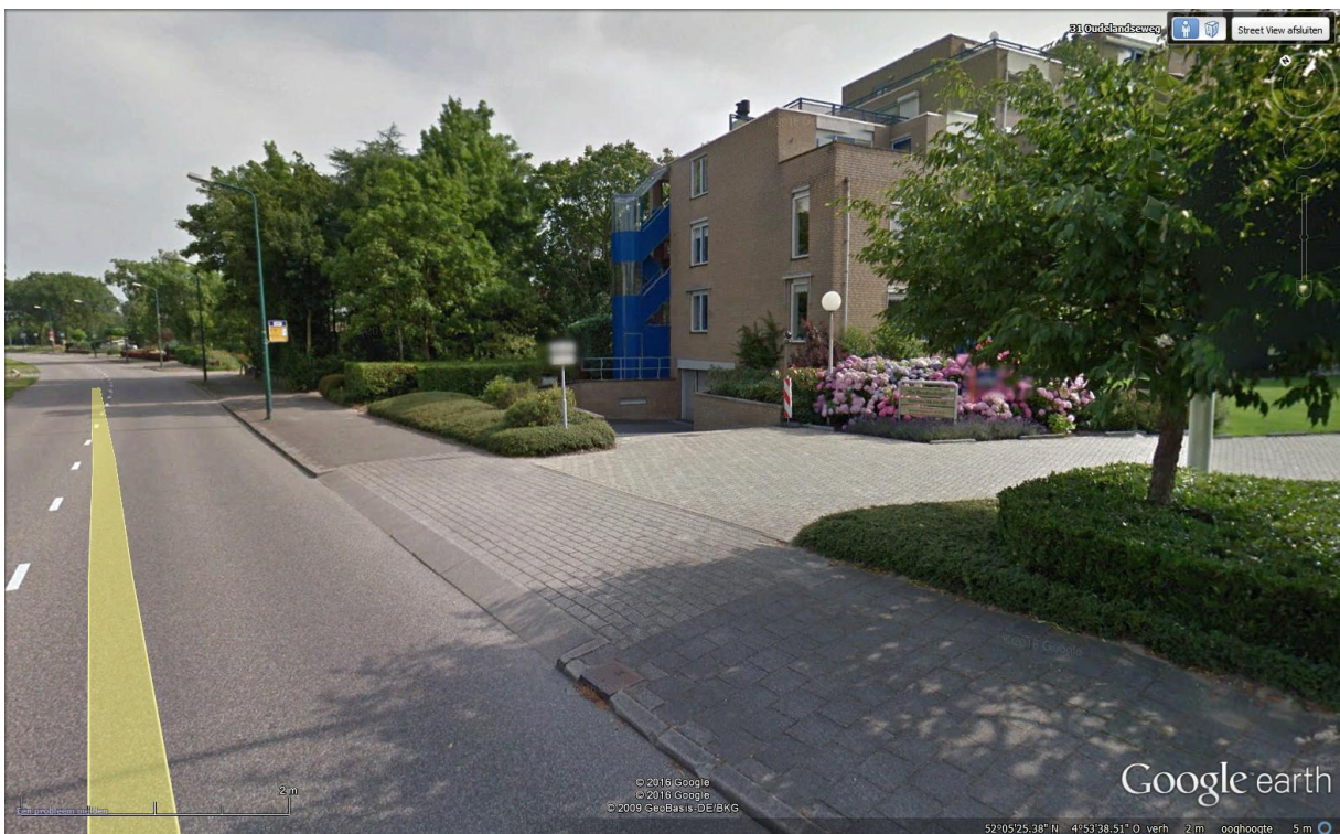
Figuur 2: Ingang parkeergarage appartementencomplex Brediushage
