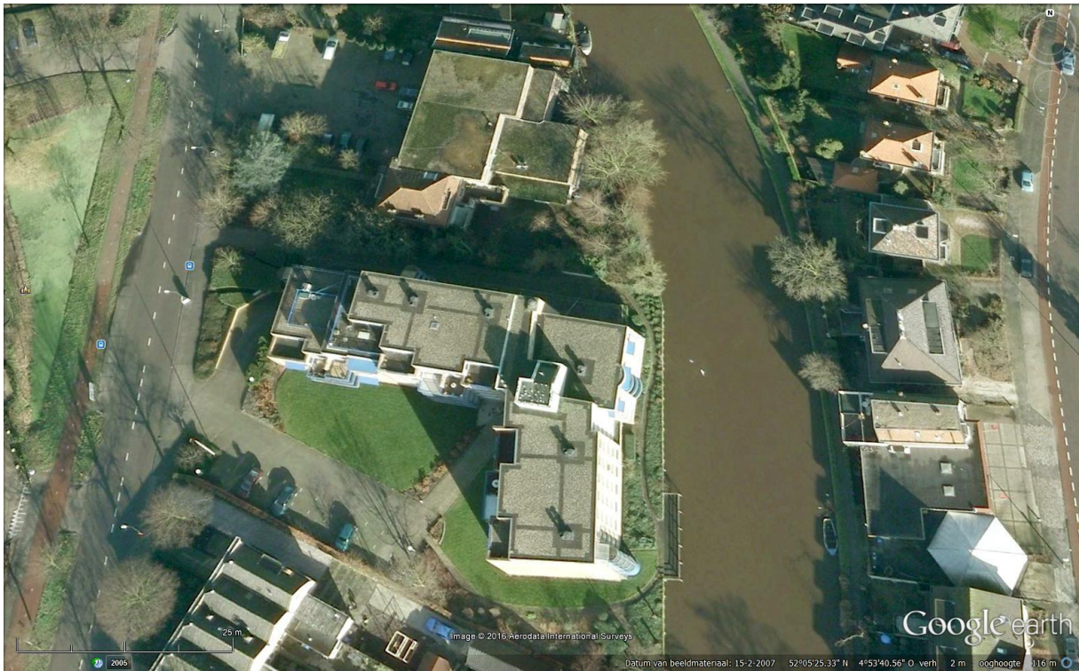
Figuur 1: Luchtfoto Situatie
