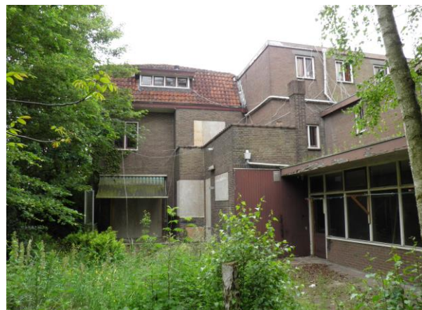
Figuur 3. Achterzijde van de woning naast het pakhuis.
