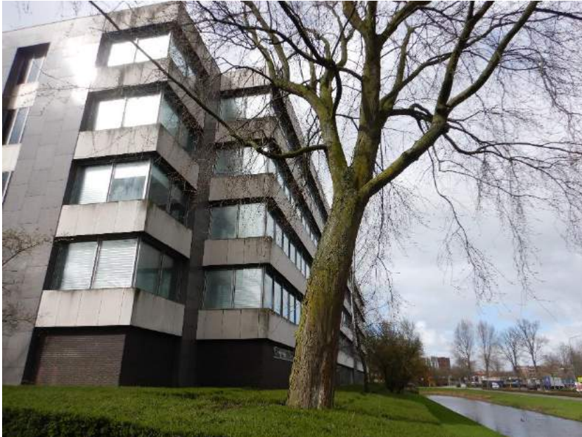
Afbeelding 1.2: Het kantoorpand en de watergang evenwijdig aan de Polanerbaan te Woerden.
