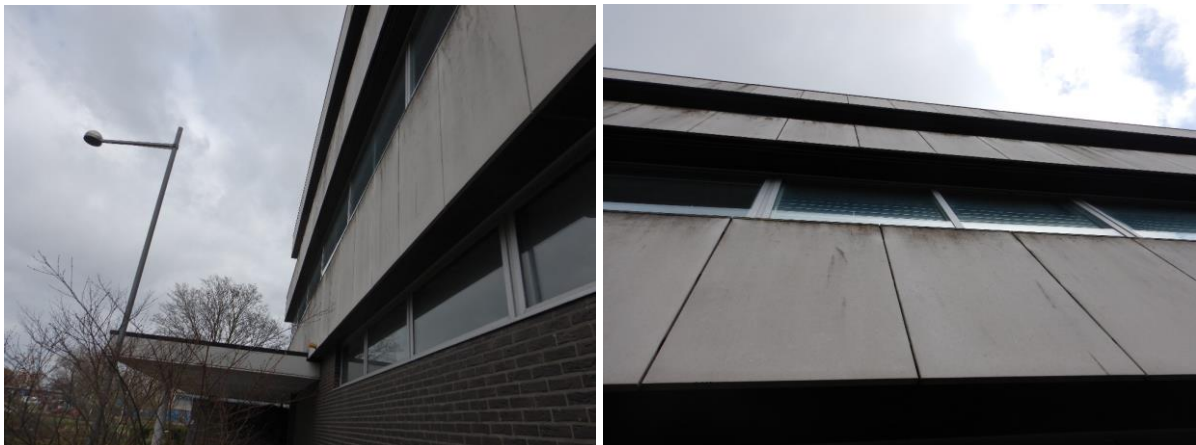
Figuur 5.1: twee foto's van de gevelplaten van het kantoorpand en de beschikbare ruimte achter de platen.
