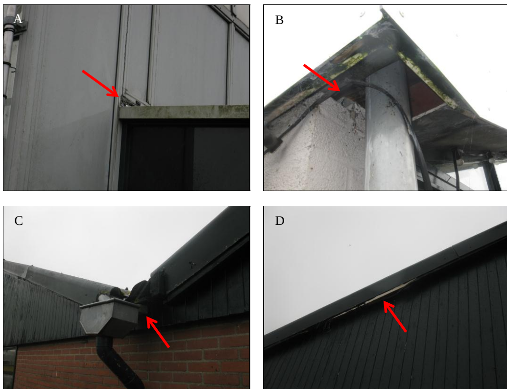
Foto's A-D. Openingen in de aanwezige bebouwing van het huidige tuincentrum aan de Geestdorp 30A die potentieel geschikt zijn als invliegopening voor vleermuizen.
