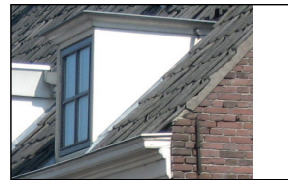
overwegend doorlopende goot
