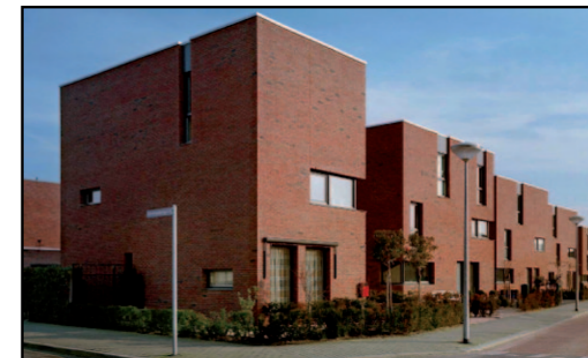
kopgevel zorgvuldig vormgegeven
