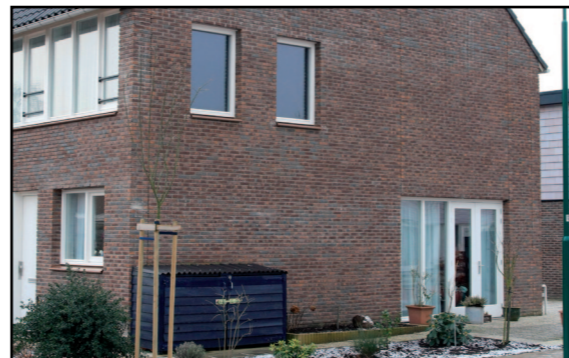
kopgevel zorgvuldig vormgegeven
