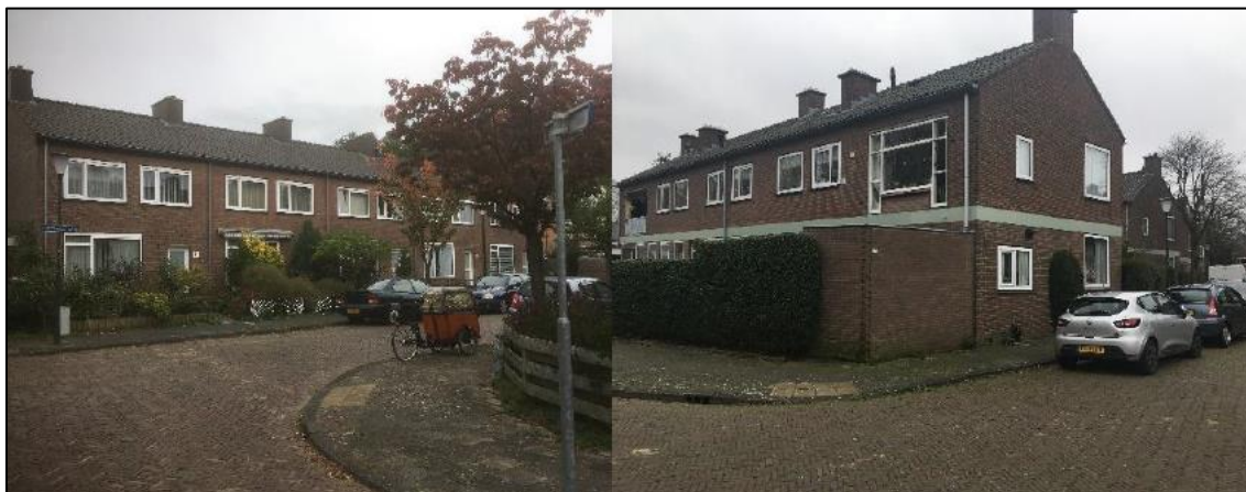
Figuur 32: Bestaande bebouwing, ingetogen architectonische articulatie
