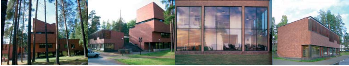
voorzieningen in baksteen uitgevoerd
