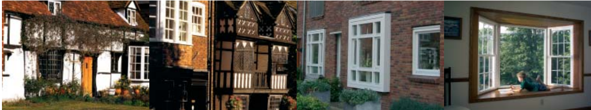
variatie in gevelopeningen door erkers, nissen, overstekken
