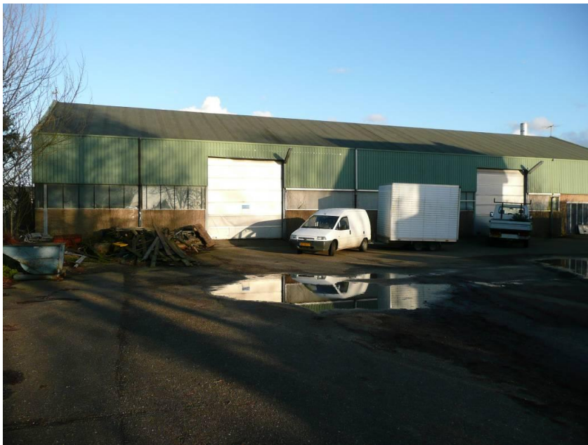
Foto 1 Beeld van het bedrijfsgebouw voor de kas
