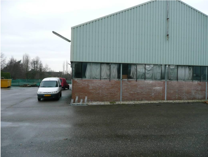
Foto 3 Beeld van de zuidzijde bedrijfsgebouw
