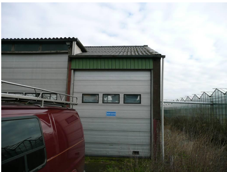
Foto 2 Beeld van bedrijfsgebouw achter woning 102b
