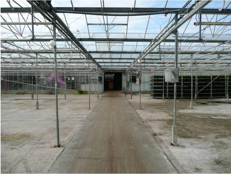
Foto 3 Beeld van kasruimte met betonvloer
