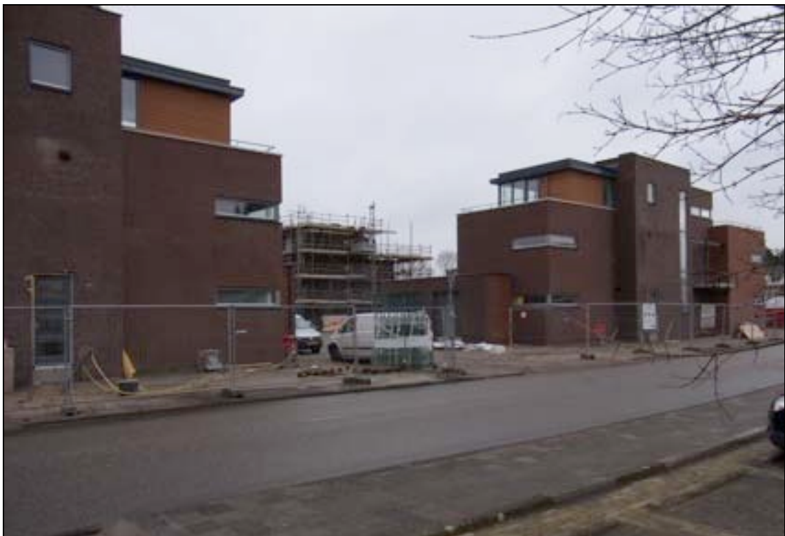
Afbeelding 6: In aanbouw zijnde woonbebouwing (februari 2012).
