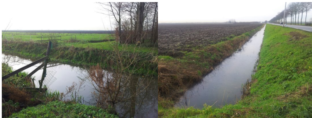
Figuur 3.2 Watergangen bij het sportpark (links) en langs de Hoogeveenseweg (N455) (rechts)
