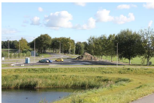
Nieuw aangelegde carpoolplaats.
