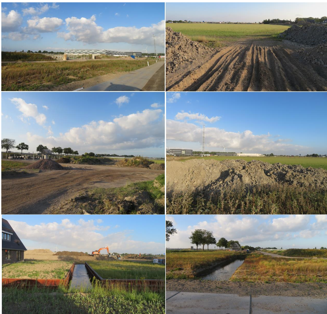
Foto-impressie plangebied. De onderste twee foto's geven het plangebied respectievelijk op de achtergrond (met graafmachine) en rechts van de sloot aan.
