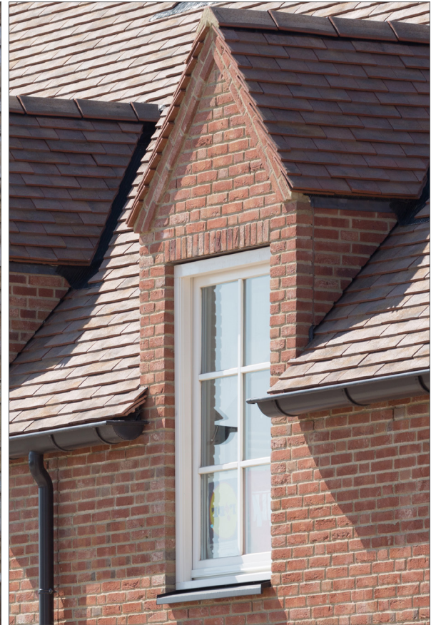
metselwerk, kozijn, leipan, goten en hwa vormen een geheel
