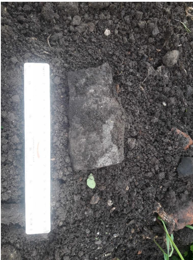
Foto 12: Asbestverdacht materiaal, maaiveld inspectie 5 oktober 2020
