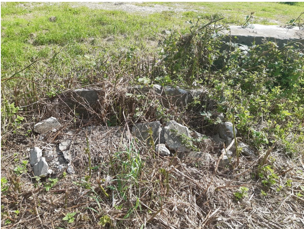
Foto 2: Betonnen brokken nabij het toegangspad naar perceel 2150
