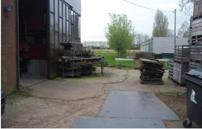
foto 1: verharding van betonplaten en grind
