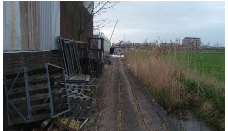
foto 4: achterzijde van de loods
