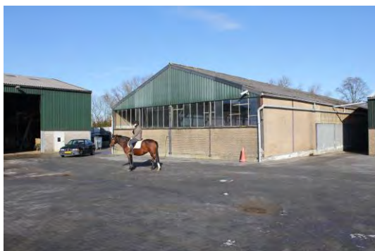
De te slopen binnenhal.
