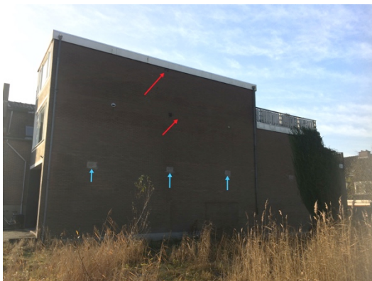
Afbeelding 4 & 5: Rode pijlen openingen in spouwmuur Zuidkade nr. 32, Blauw dicht gemetselde openingen
