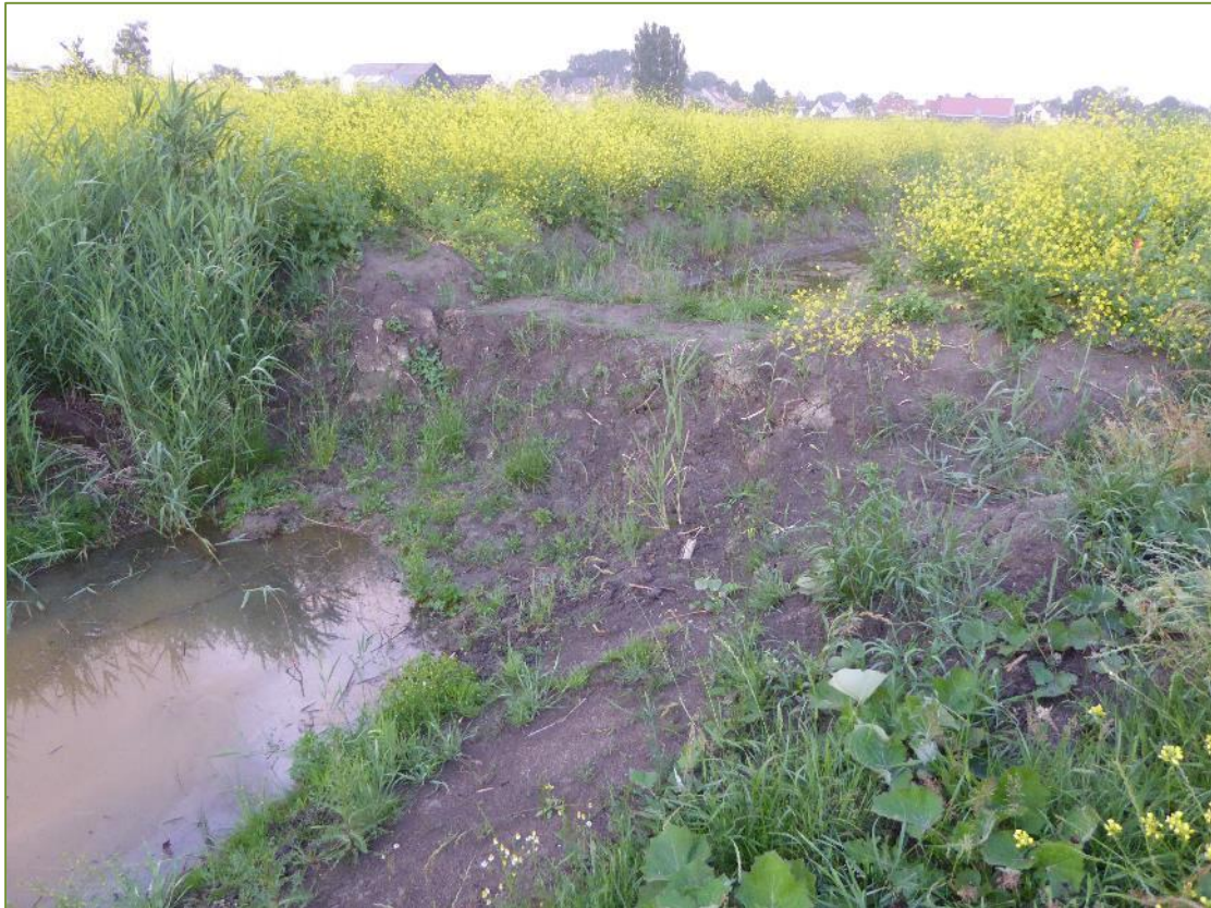
Foto 7: een foto van de waterscheiding in de vorm van een gronddam. Aan de linkerkzijde het oude slootprofiel, aan de achterzijde de nieuw gegraven sloot.
