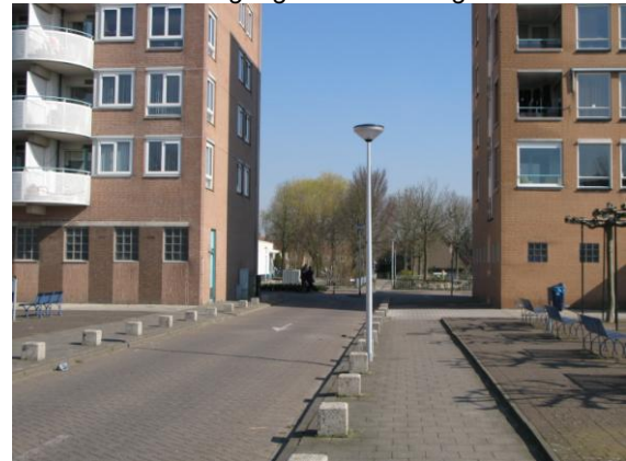
De bestaande doorgang tussen de flatgebouwen.
