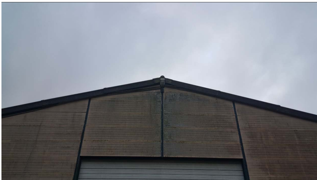
Figuur 3.3 Verblijfplaats steenuil in de nok aan de achterzijde van de schuur aan de Plasweg 18. Zie ook figuur 3.2.
