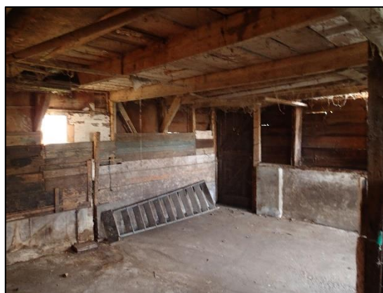
Foto 4: Binnenkant van gebouw 3
