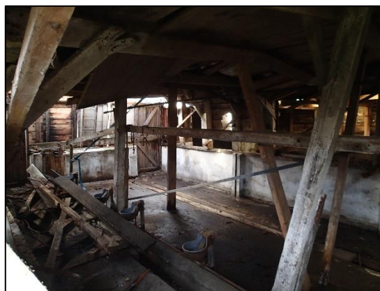
Foto 2: Binnenkant van gebouw 2
