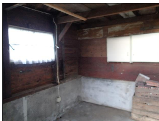
Foto 8: Binnenkant van gebouw 5
