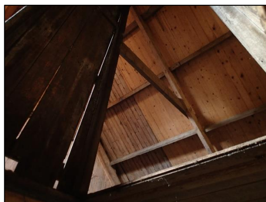
Foto 10: Binnenkant van gebouw 6
