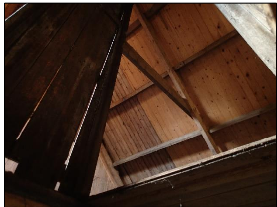
Foto 16: Houten constructie gebouw 6
