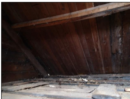
Foto 7: Binnenkant van gebouw 5
