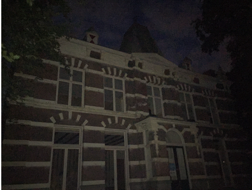
Afbeelding 3: Gevel voorzijde hoofdgebouw
