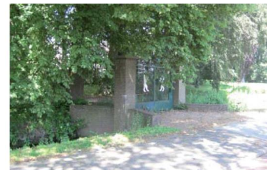
De oorspronkelijke hoofdentree van Beresteijn blijft bestaan als toegang voor voetgangers
