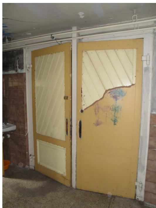
Afb. 43: deuren begane grond, de bovenpanelen oorspronkelijk met glas.
