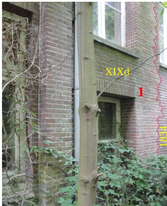
Afb. 39: nieuw metselwerk uitbreiding XIXd
