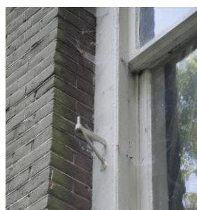
Afb. 38: geprofileerd kozijn met luikgeheng
