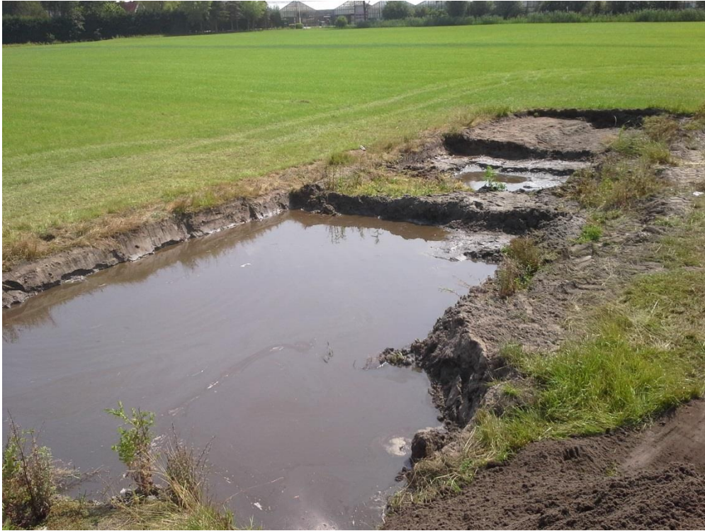
Foto 3: Zicht in zuidelijke richting op de ontgraving.
