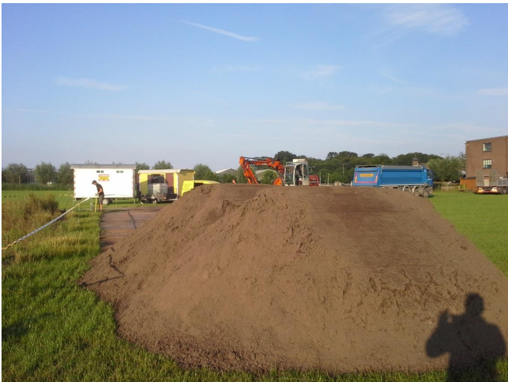
Foto 4: Zicht op de in voorraad liggende aanvulgrond.
