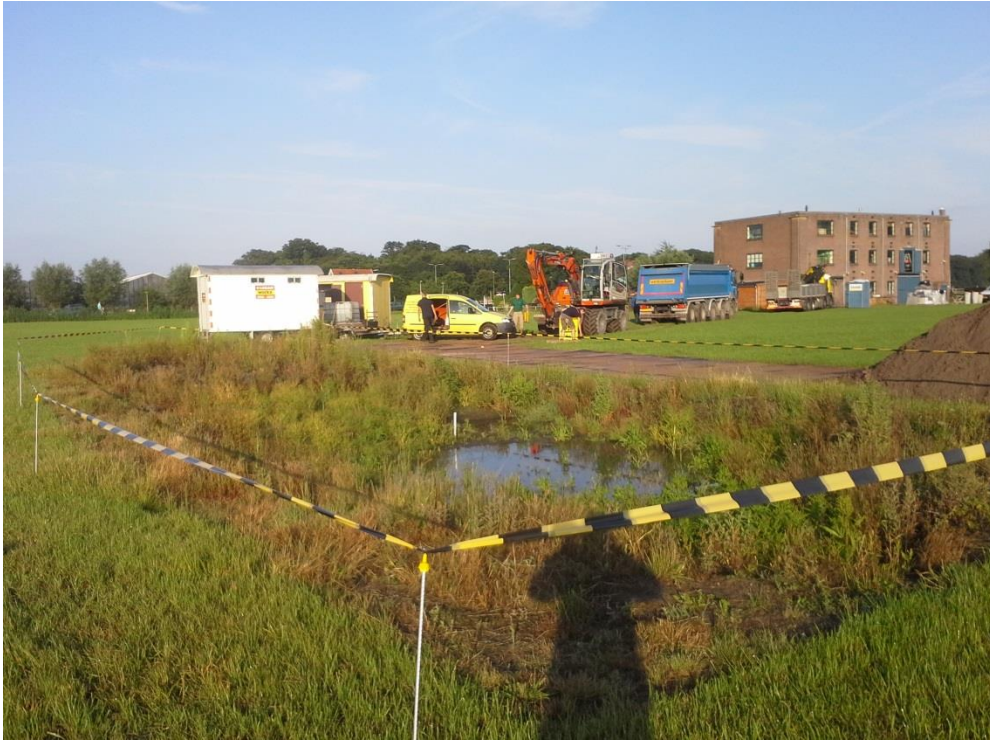
Foto 1: Zicht in oostelijke richting op de saneringslocatie.
