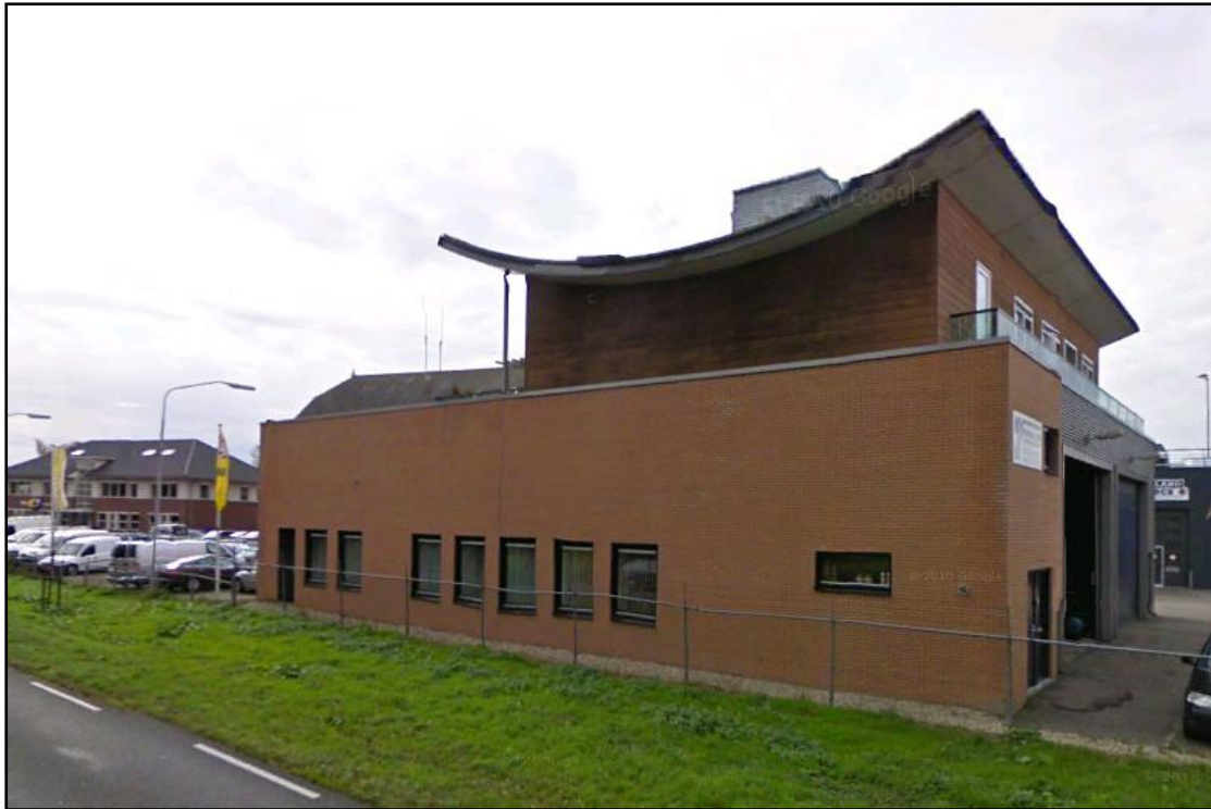
Transportbedrijf Fa. M. Verwaal en Zn, zijde Schoonhovenseweg
