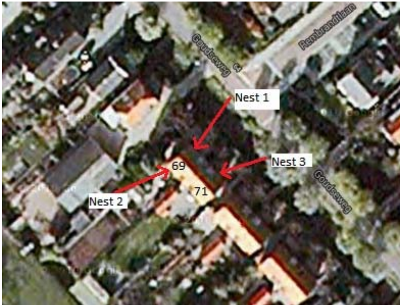
Figuur 3.2 Huismus nesten onder dakpannen
