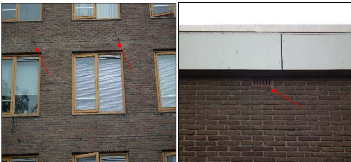
Open stootvoegen en ventilatieroosters in de bebouwing geven mogelijk toegang tot voor vleermuizen geschikte achterliggende holtes.
