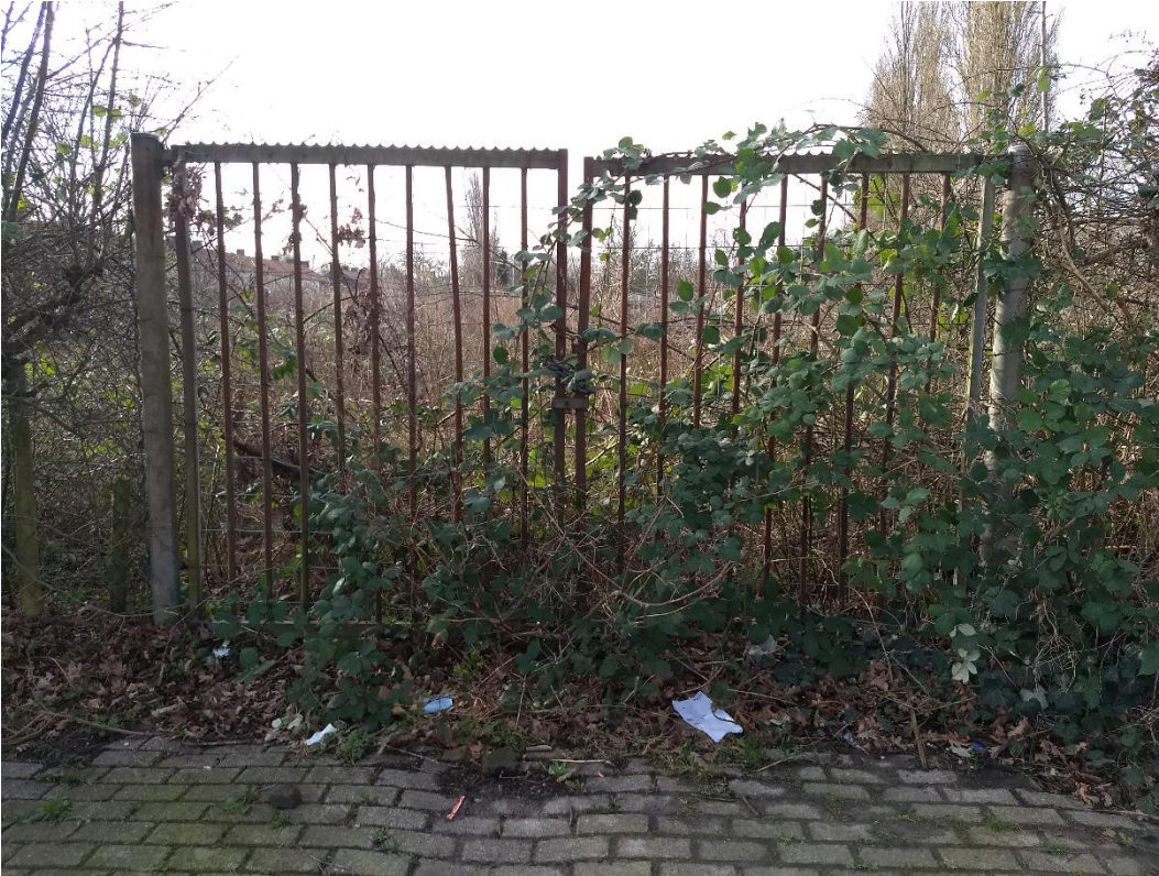
Braakliggend en volledig verruigd terrein aan de noordzijde.
