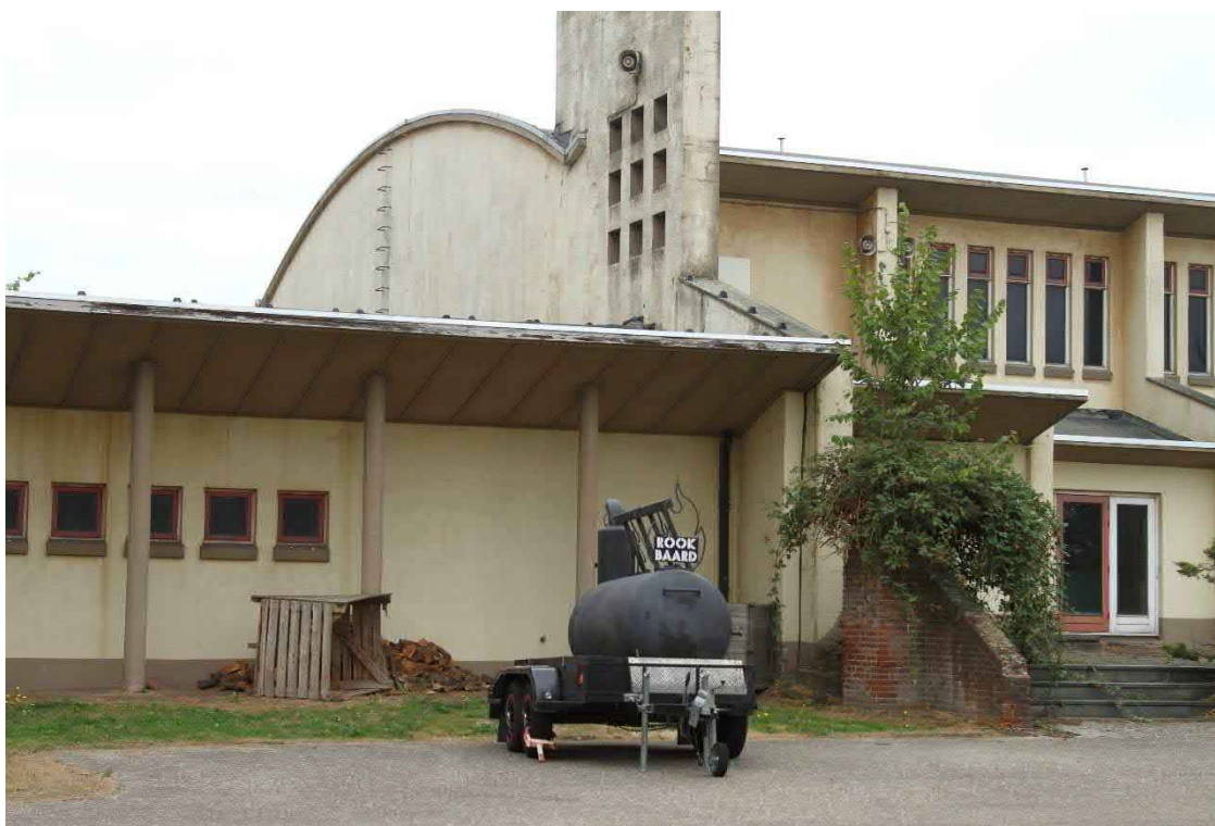
Foto 2: De sporthal, gezien vanaf de westkant. De daken zijn bedekt met bitumen.
