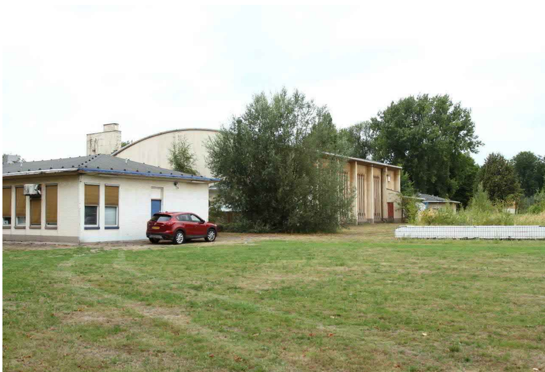
Foto 1: Zicht op de sporthal met bijgebouwen, gezien vanaf de zuidkant.
