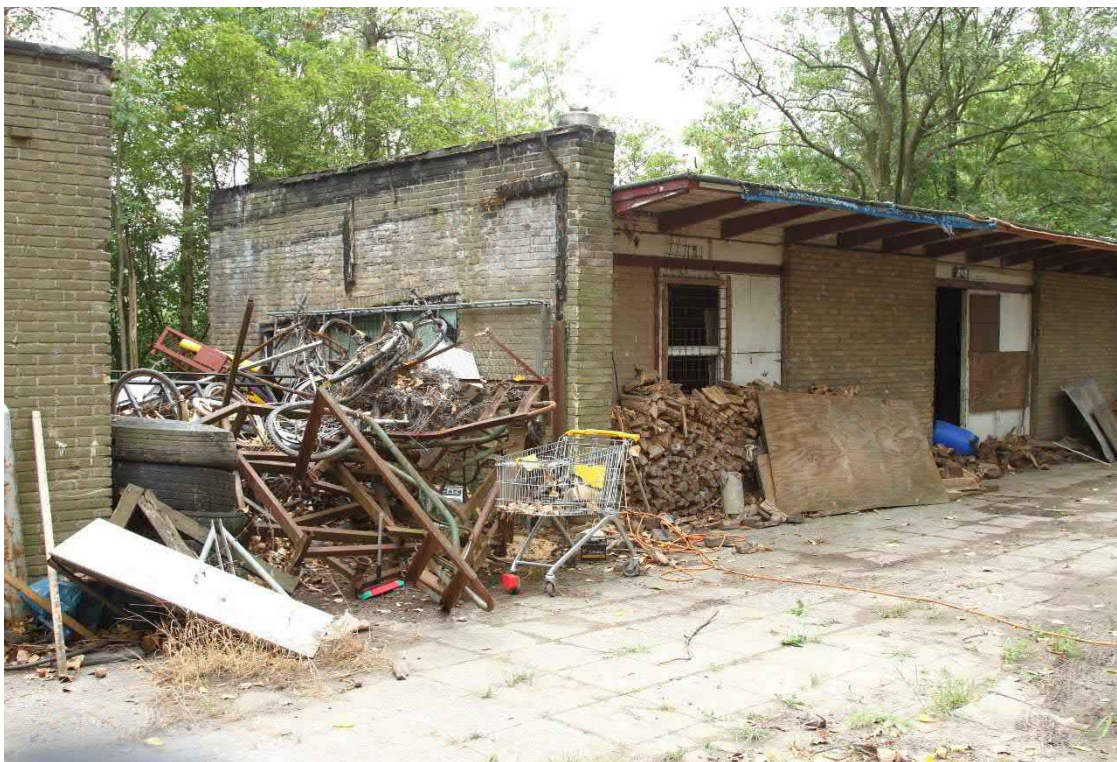
Foto 5: Deel van de bijgebouwen aan de oostzijde van het plangebied. De bijgebouwen hebben spouwmuren, en zijn in slechte staat. Rondom de bijgebouwen ligt veel opslag/rommel.
