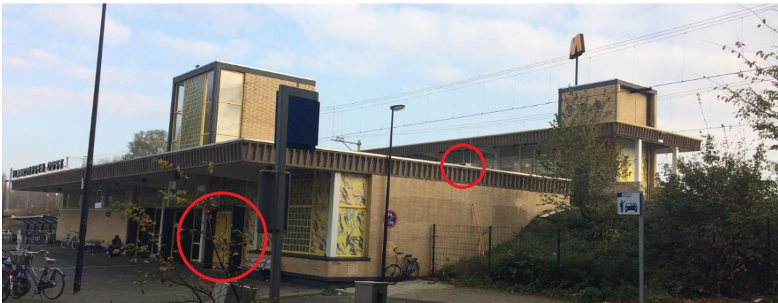
Afbeelding 2 Deur transformatorruimte en airco
