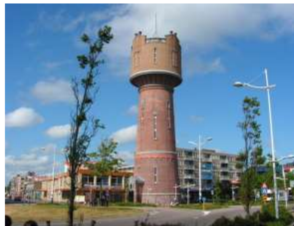
Watertoren Den Helder, gebouwd 1908 naar ontwerp van Jan Schotel en 1959-1961 verbouwd door J.H.J. Kording
