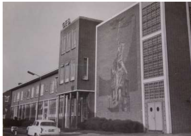
Hoflaan 15-23 Gemeentelijk Energie en Waterleiding Bedrijf, 1967. Met mozaïek van Berend Hendriks (Stadsarchief Vlaardingen)
