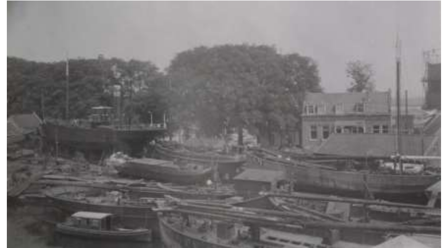
Scheepswerf A. de Jong, met een 19de-eeuwse eclectische woning met siermetselwerk en een (kleine) veranda. Rechts op de achtergrond de gashouder, 1922 (Stadsarchief Vlaardingse)
