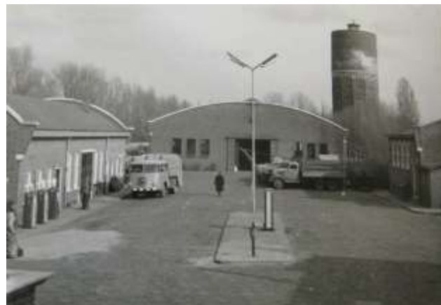
Terrein van de Gemeente Reiniging, links de werkplaats en magazijn, midden achter de garage en rechts het schaftlokaal (Stadsarchief Vlaardingen)
