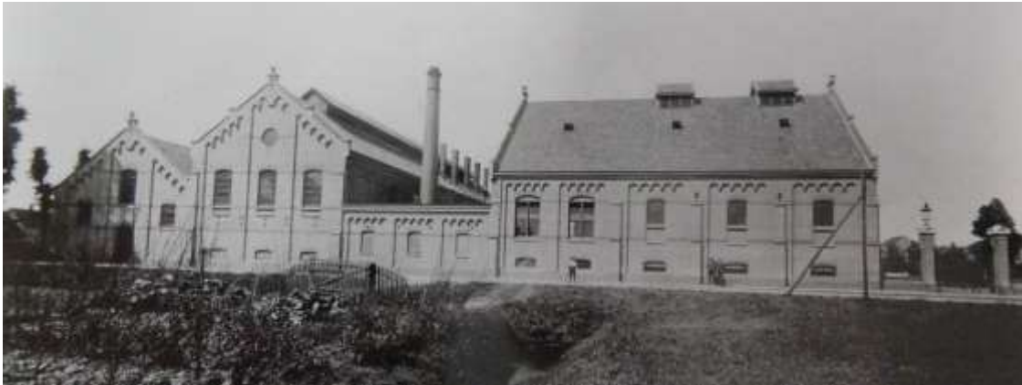
Gasfabriek aan de Hoflaan met van links naar rechts: kolenloods, stokerij, ketelhuis, machinekamer/zuiverhuis en hekwerk, 1902 (Stadsarchief Vlaardingen)
