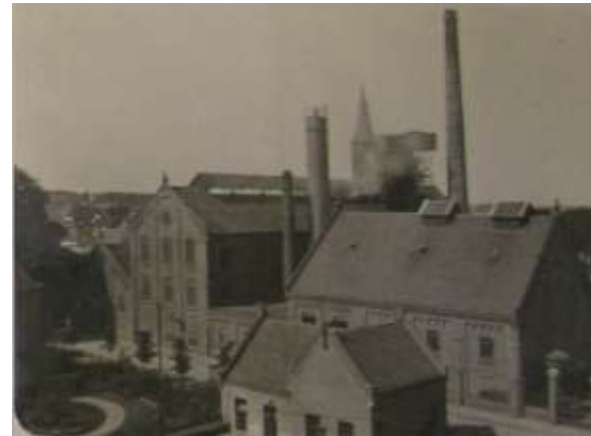
Gasfabriek, gezien richting Buizengat, waarschijnlijk met de ammoniakfabriek (VB 26) op de voorgrond en het ketelhuis/stokerij (VB 8), de kolenloods/kantoor (VB 4) en het zuiverhuis/machiniekamer (VB 6) op de achtergrond (Stadsarchief Vlaardingen)
