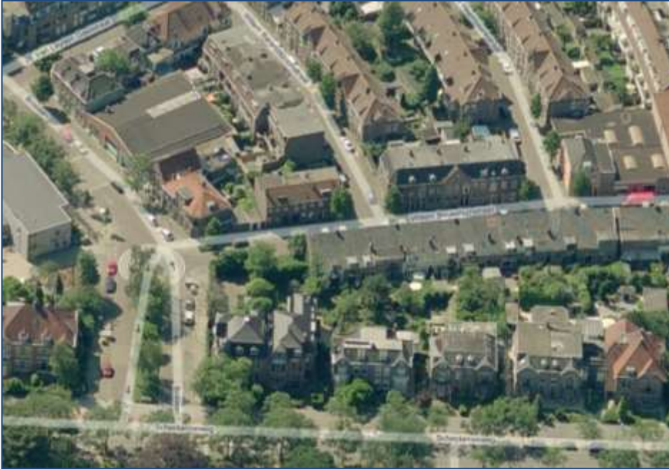
Schiedamsseweg (Bron: Bing Maps) Afbeelding: plangebied gezien vanuit het noorden; op de voorgrond de villa's aan de
