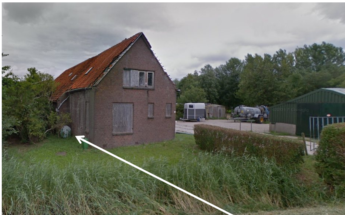
Foto 3: overzicht Zuidbuurt 77 met ligging bovengrondse petroleumtank
