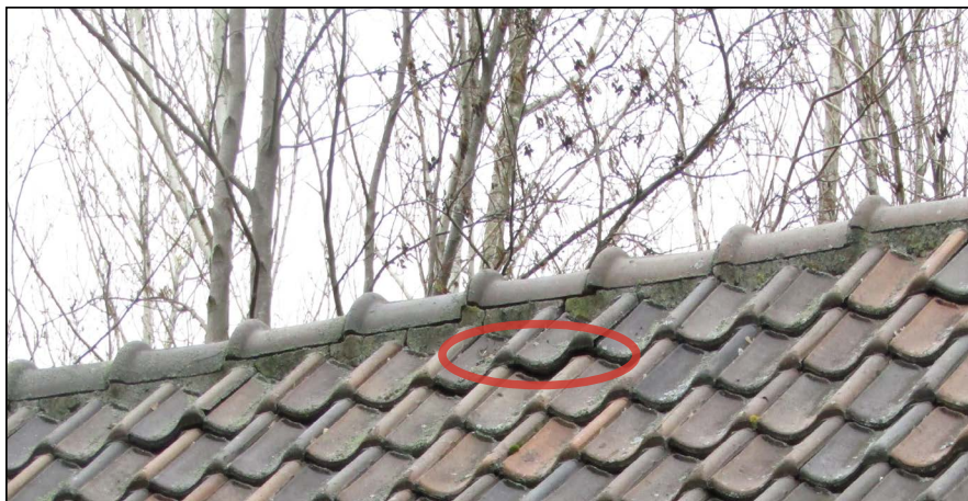
Figuur: Figuur: onder de dakpannen van de westelijke woning kunnen vleermuizen verblijven.
