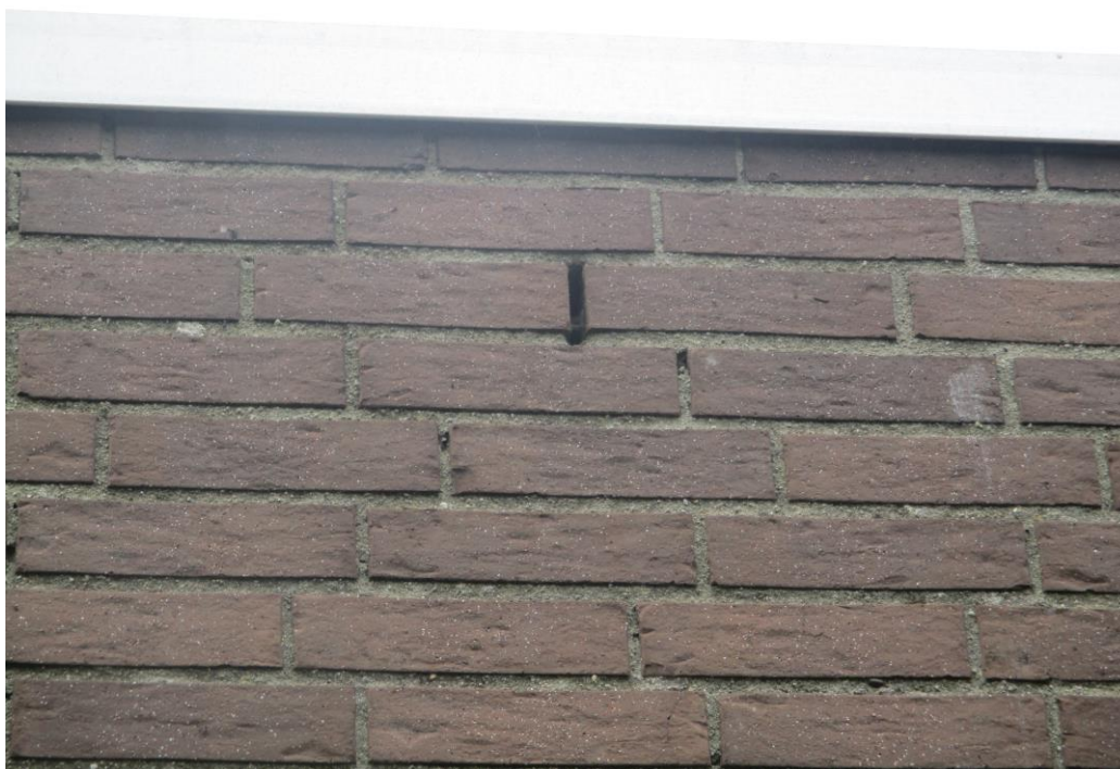
Figuur 3 De aanwezige stootvoegen op de bebouwing aan Claudius Civilislaan welke mogelijk gebruikt kunnen worden door vleermuizen.
