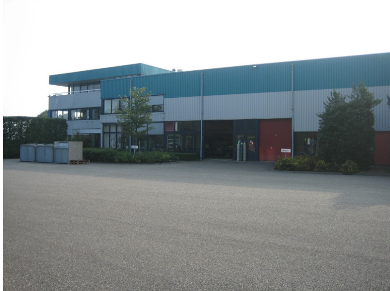
figuur 10: De werkplaats met daarachter (links op de foto) het kantoor.
