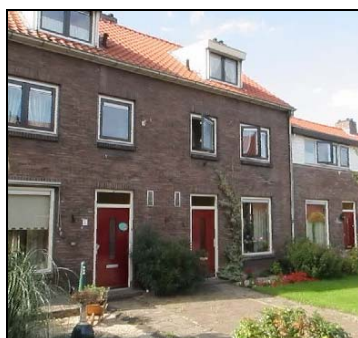
Zuidwestelijk deel: afwijkende hoekwoningen met dakkapel voor en achter (Lombokstraat)
