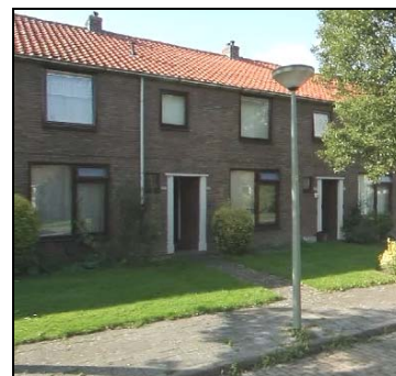
Middenwestelijk deel: duplexwoningen worden omgebouwd tot eengezinswoningen (Timorstraat)
