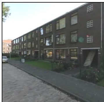
Middenwestelijk deel: portiekflats (Floreslaan)
