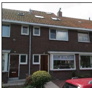
Zuidelijk deel: een enkele "verlengde kap" (Surinamesingel)
