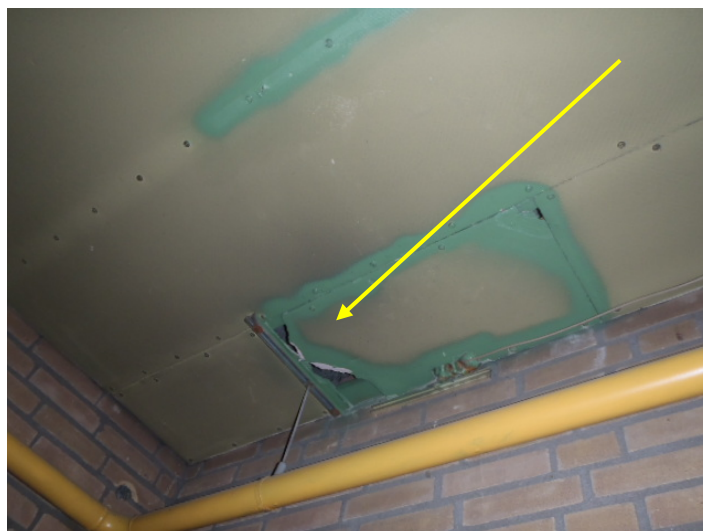
foto: Plafond installatieruimte zwembad
