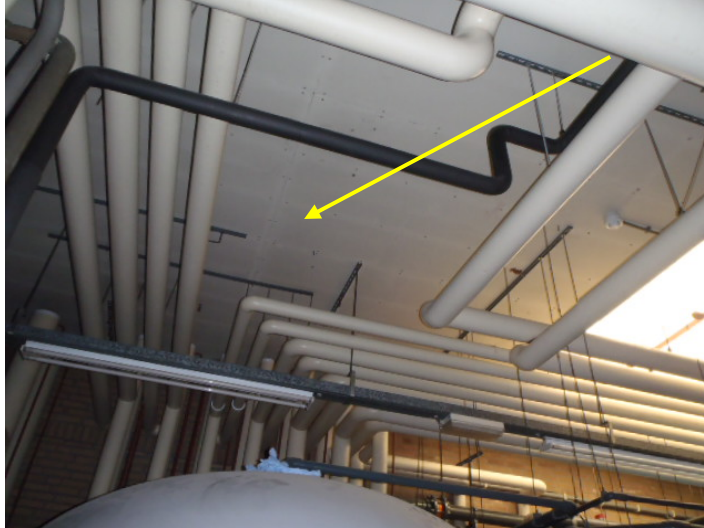
foto: Plafond installatieruimte zwembad
