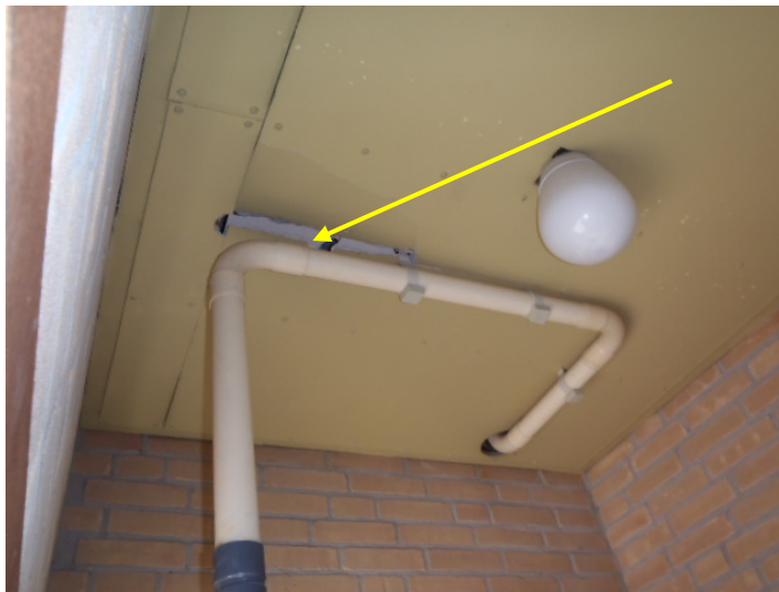
foto: Plafond chemicaliënruimte (chloorbleekloog)
