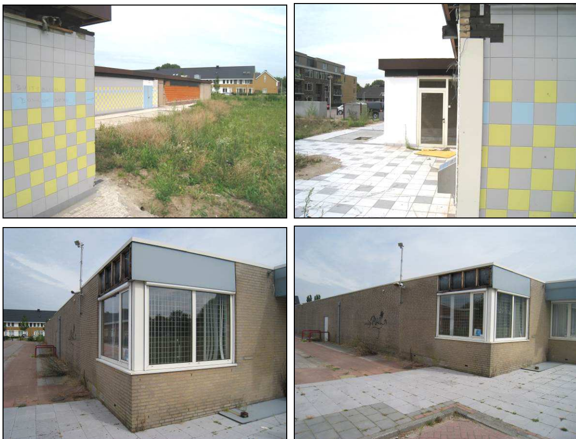
Figuur 3. Aanzicht van de te slopen opstallen in het plangebied Monnikenhof te Vianen.
