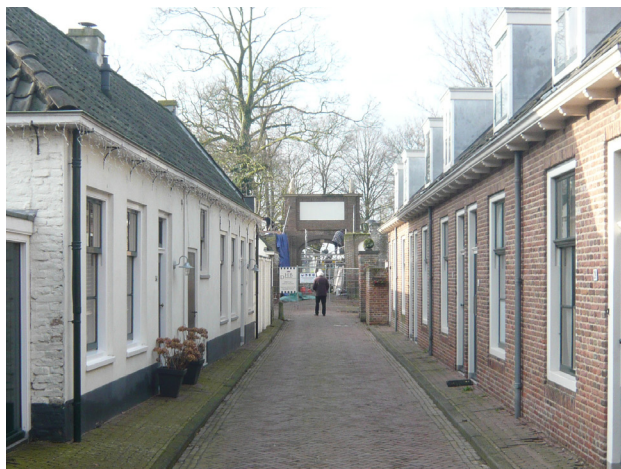
Het Hofplein met zicht op de recent gerestaureerde Hofpoort.
